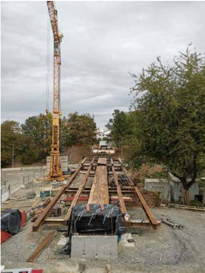
Fotos: Karin Lauser, das Trag- und Lehrgerüst wird montiert, Okt. 2023
