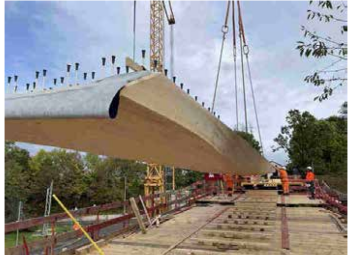
Foto Konrad Fuchs, Ablegen des Holzträgers auf dem Lehr- und Traggerüst
