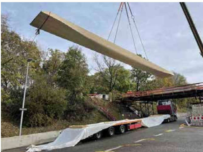
Foto Konrad Fuchs, Einhub eines Holzträgers vom Schwertransporter
