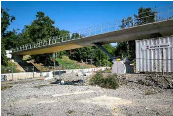
Foto, Erwin Grimme, Querung Seeblickweg, Baustelle nach Rückbau des Lehrgerüstes
